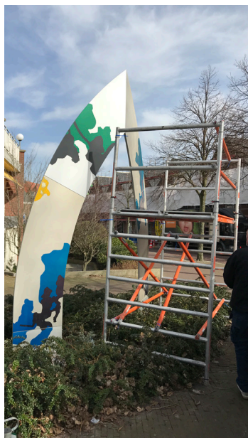
Monteren van de nieuwe platen
